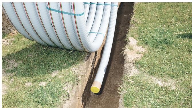
Obr. 52 Otevírání svazků ve vrstvách
