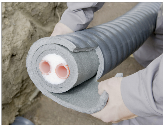
Obr. 9 Odizolování trubky
