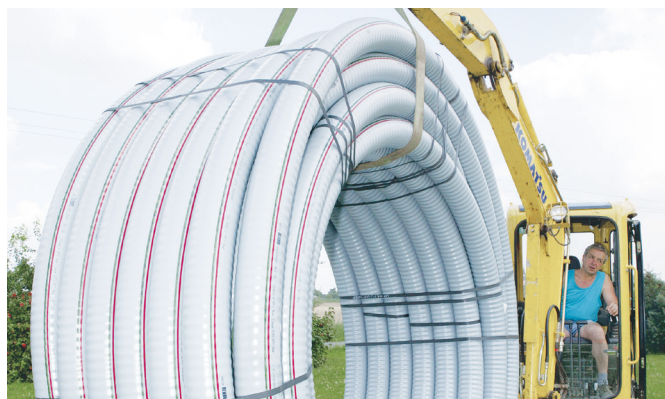
Obr. 47 Uchopení pomocí bagru
