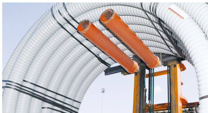
Obr. 48 Nabírání pomocí vysokozdvizného vozíku
