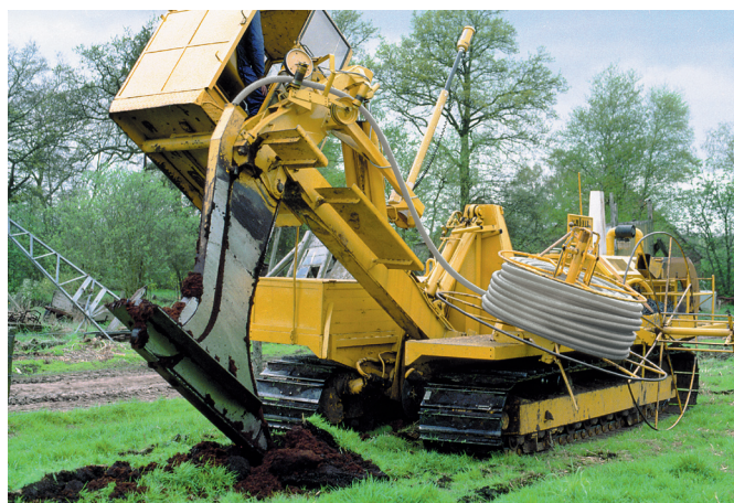
Obr. 36 Metoda zapluhování
