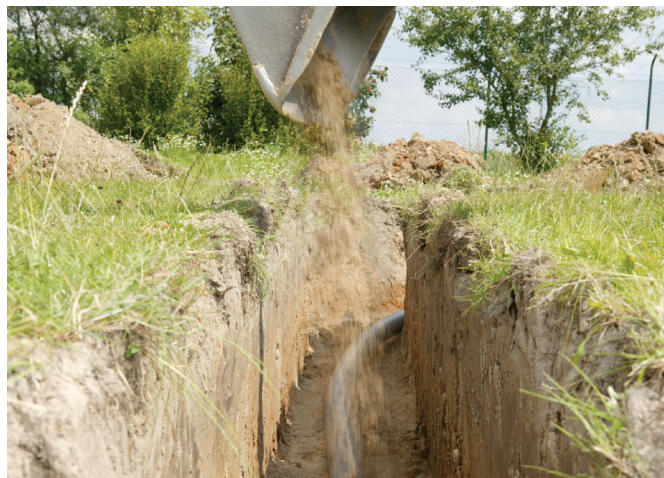
Obr. 56 Zaplnění výkopu pískem
